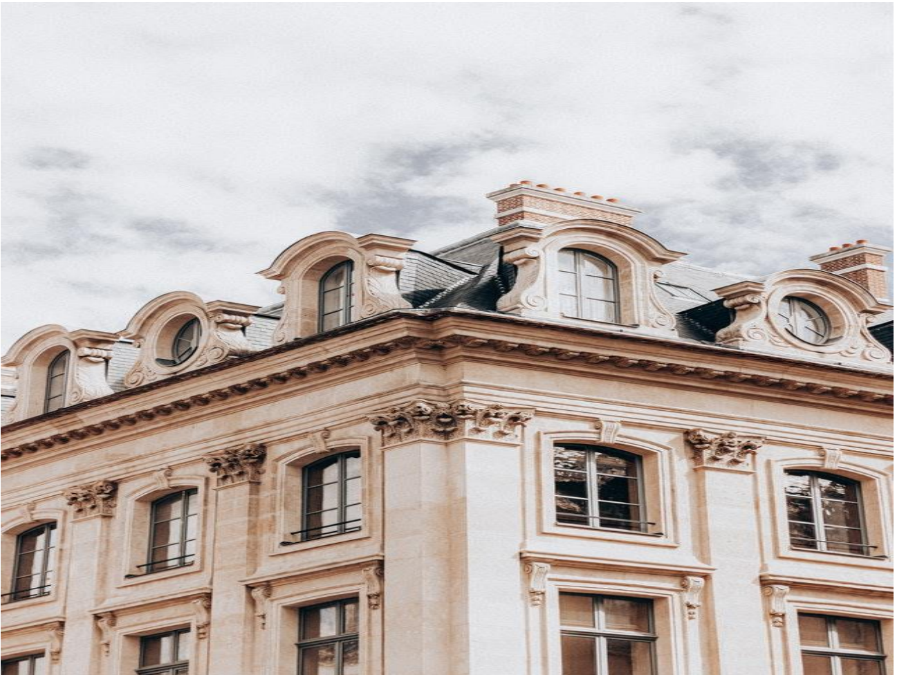
Fig. 4: Le diverse tipologie di finestre regolari, ad arco e rotonde in un edificio storico
