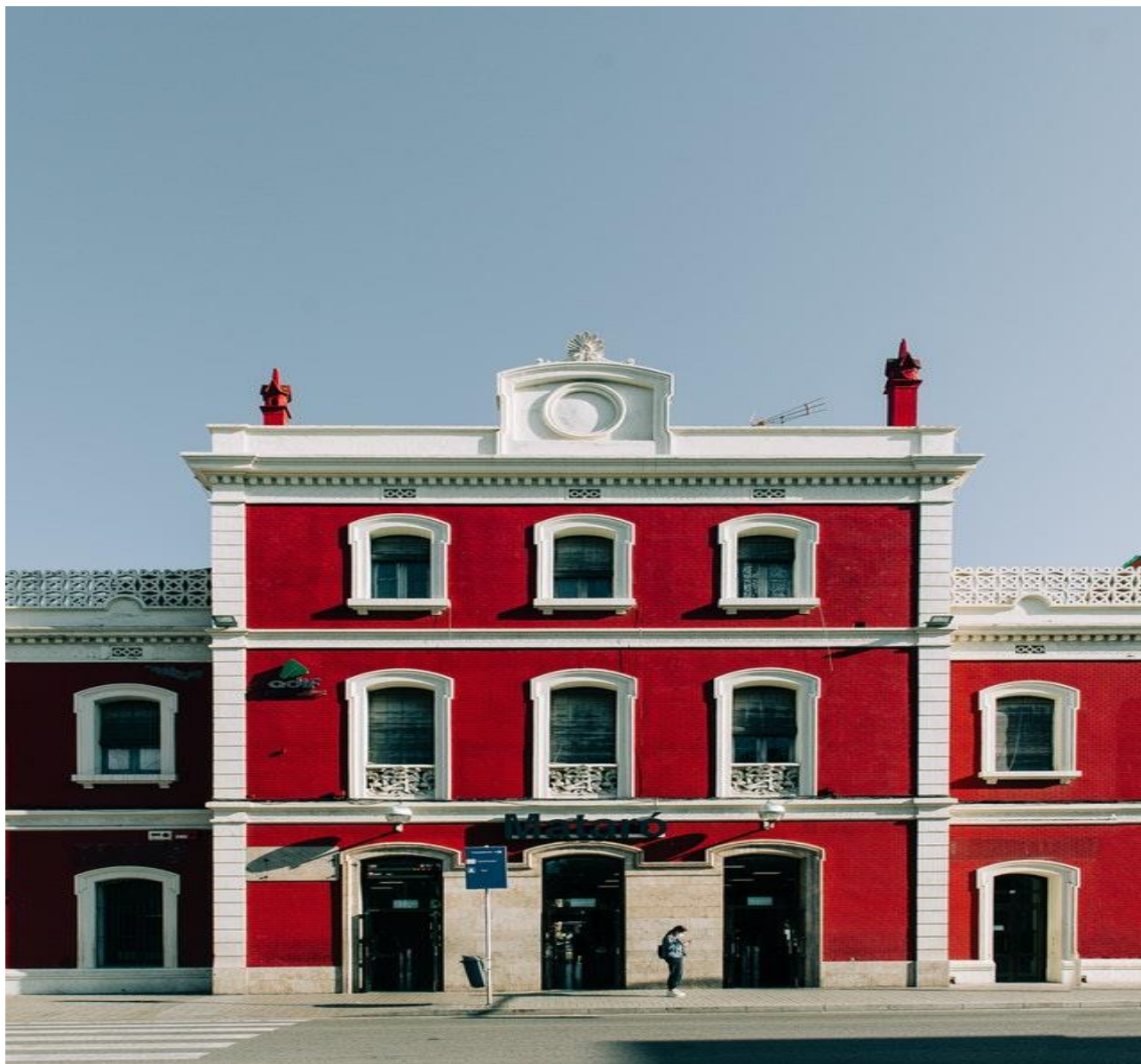
Fig. 5: Palazzo ristrutturato in stile neoclassico
